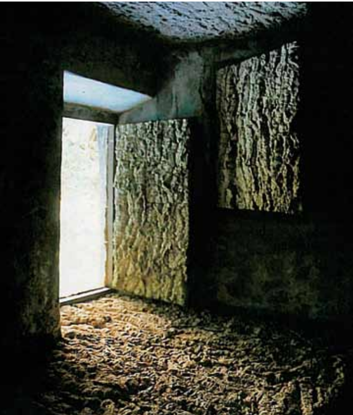
Convento dos Capuchos (séc. XVI). Todas as celas e aposentos dos frades foram revestidos com cortiça.
